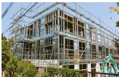
同社独自開発のスチールパネル工法による建築風景
